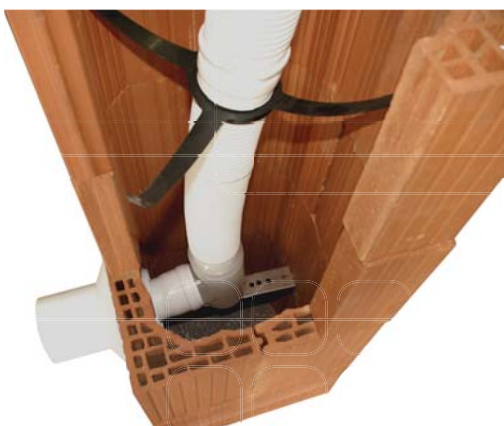
3. Protážení komínovým tělesem a spojení s patním kolenem
