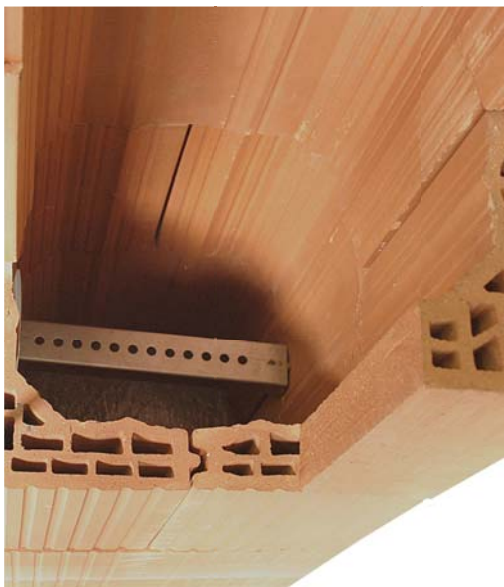
1. Příprava upevnění patního kolena
